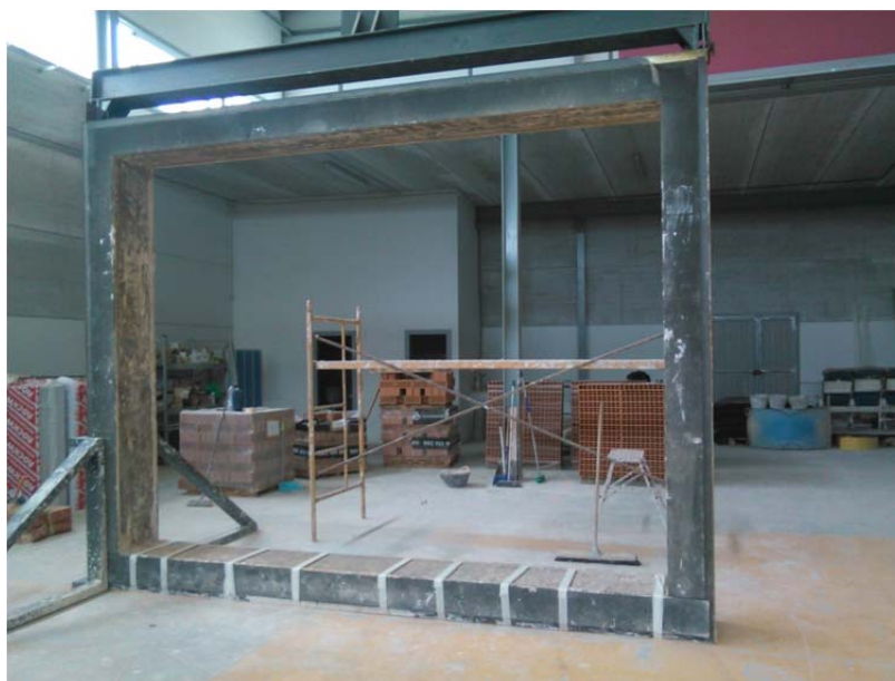
Fotografía 02. Premarco utilizado para la realización del montaje
